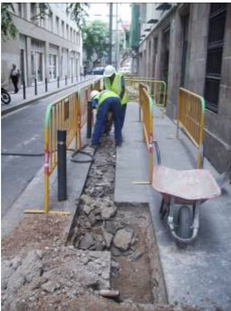
Foto 2. Obrers rebaixant la rasa del carrer Sant Ramon
